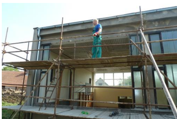
Letní rekonstrukce tělocvičny.
