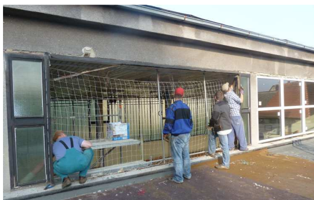
Výměna oken v tělocvičně
